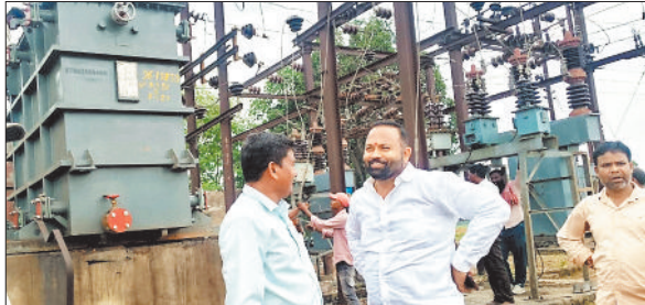
ट्रांसफार्मर लगावते बिजली कर्मी।
